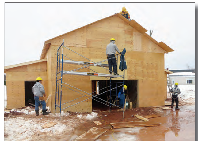
Durant le projet, les travailleurs ont fait face à toutes les conditions météo possibles. Le 14 janvier, la boue dominait.
